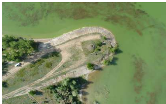
Рисунок 3.19 – Пример техногенных берегов В) Бетонный откос с. Жуковская.
