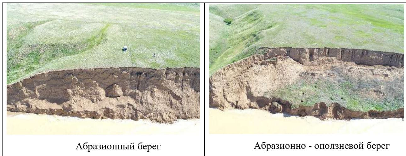
Рисунок 4.26. – Абразионный и абразионно-оползневой тип берега возле станции Нагавская.
